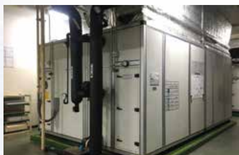
งานติดตั้ง AHU
