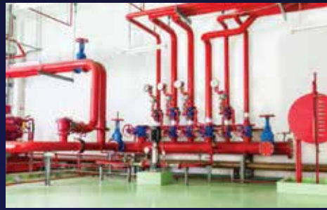
งานติดตั้งระบบดับเพลิง (SPRINGER SYSTEM)
