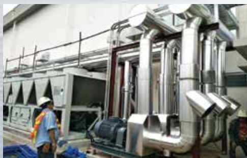
งานติดตั้ง CHILLER
